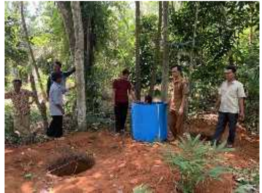
Gambar 10. Merangkai Cetakan Buis Beton
