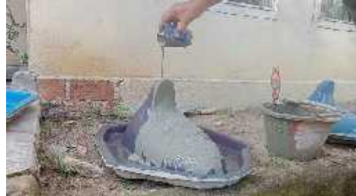
Gambar 4. Penuangan Adukan Aci Semen ke Atas Cetakan Kloset
