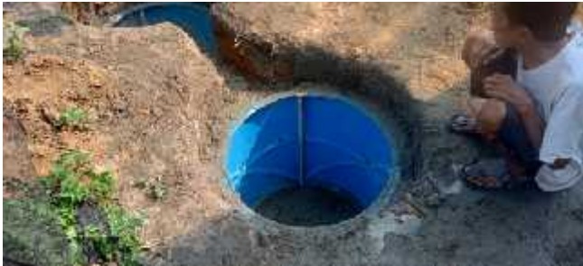
Gambar 11. Lubang Septitank dan Resapan Setelah dilakukan Pengecoran
