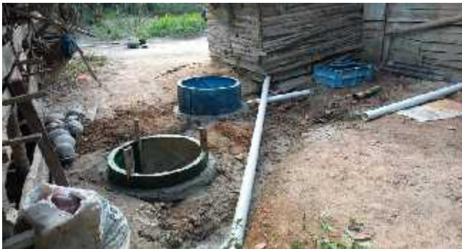
Gambar 12. Pengecoran Dudukan Kloset
