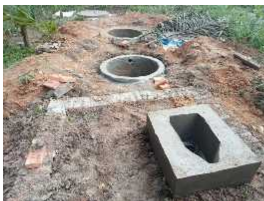
Gambar 13. Dudukan Kloset, Lubang Septitank dan Resapan Setelah Cetakan Dibuka Untuk Proses Finishing
