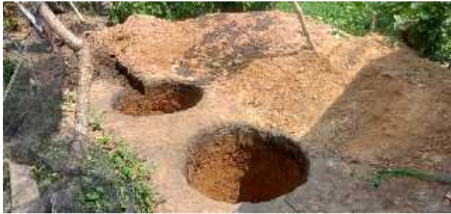
Gambar 9. Lubang Septitank dan Resapan
