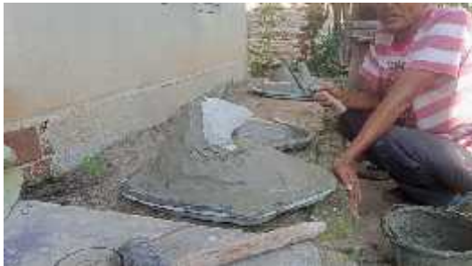
Gambar 6. Pemasangan Leher Angsa yang Telah Disiapkan Sebelumnya
