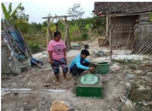
Gambar 3. Pembangunan Sarana Sanitasi Dasar di Desa Sidosari
