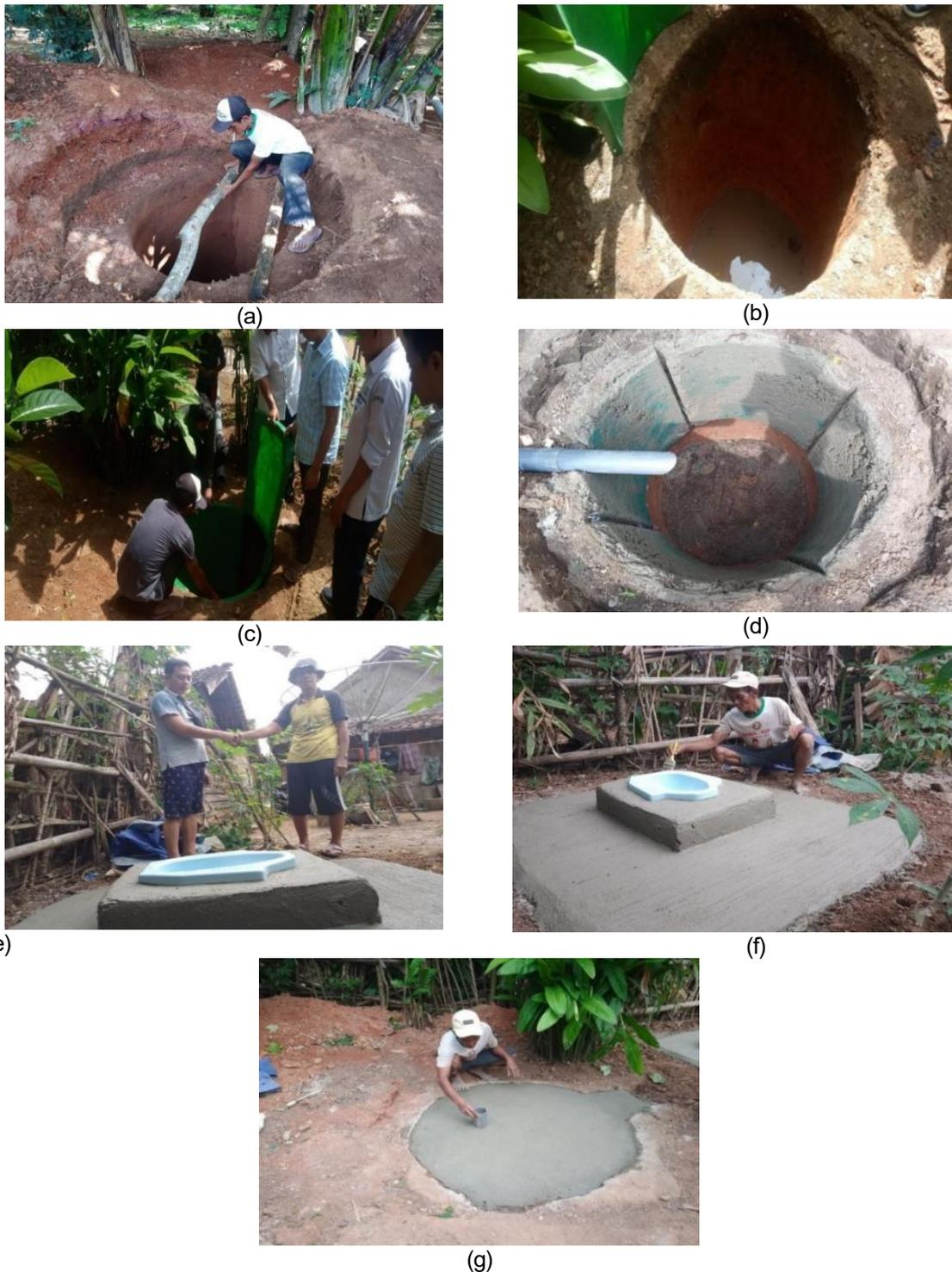
**Gambar 5.** Proses Pembuatan Lubang Jamban Keluarga, (a) Pembuatan Lubang Jamban, (b) Lubang Jamban Keluarga, (c) Pemasangan Cetakan, (d) Lubang Jamban Permanen, (e) Pemasangan Kloset, (f) Finishing Kloset dan (g) Finishing Lubang Jamban Keluarga
